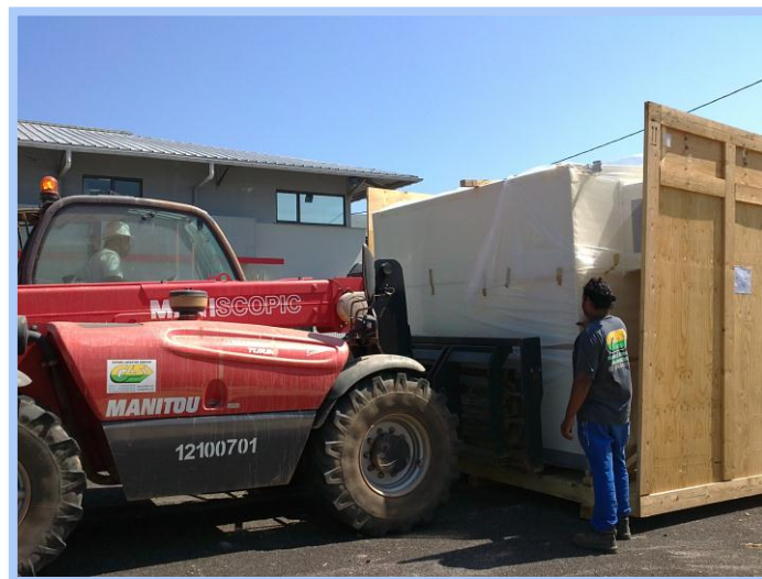
Figure 36 : réception de la cabine de la station fixe qui sera placée dans la ZR
