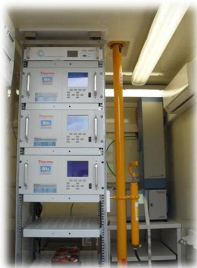
Figure 2 : analyseurs installés dans la remorque
